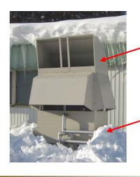
熱交換器やファンに積雪 しないようフード(各メーカーによる) を取付ける。
